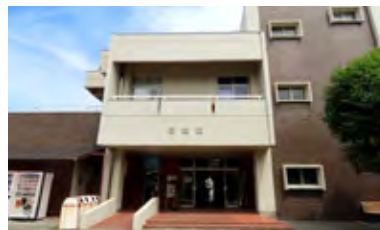
南会館 South Hall
